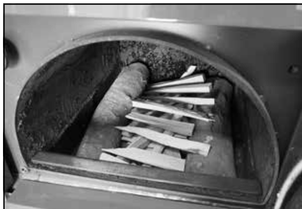
Holzsplitter quer durch die Nachlegekammer über das Zeitungspapier auflegen
